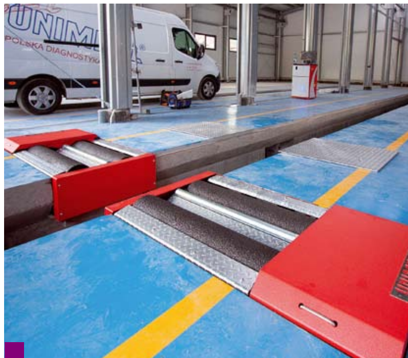
Stanowisko kanałowe – takie dość często wybierają klienci firmy Unimetal
