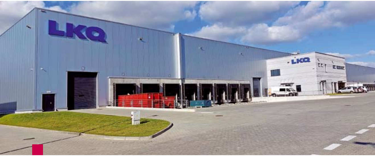
Magazyn w Modlniczce powstał na terenach kompleksu Kraków Airport Logistics. Jest tu 15 doków załadunkowych, w tym 5 wyposażonych w rampy hydrauliczne do transportu i składowania towaru
